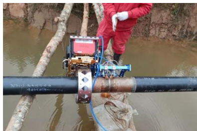
河流、洼地地区施工
