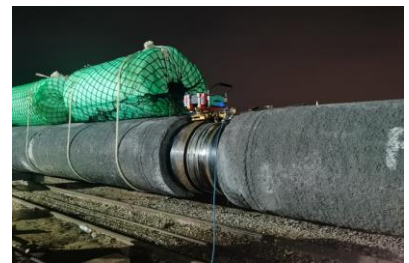
潮湿、高盐度海上铺管施工
