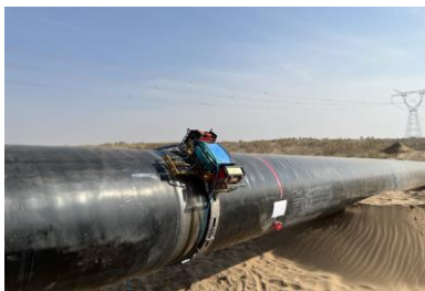
干燥、炎热沙漠地区施工
